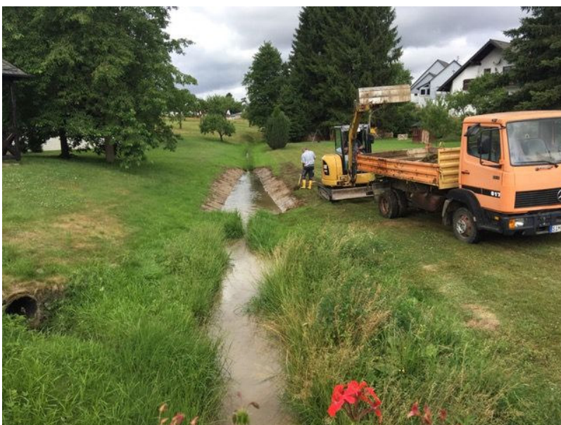
Das Bett des Bieberbachs wurde im Bereich der Brücke etwas verbreitert. Somit ist die Überflutungsgefahr bei Hochwasser wahrscheinlich doch etwas geringer. Der Unterschied im Bachlauf ist in dem Bild gut zu erkennen
