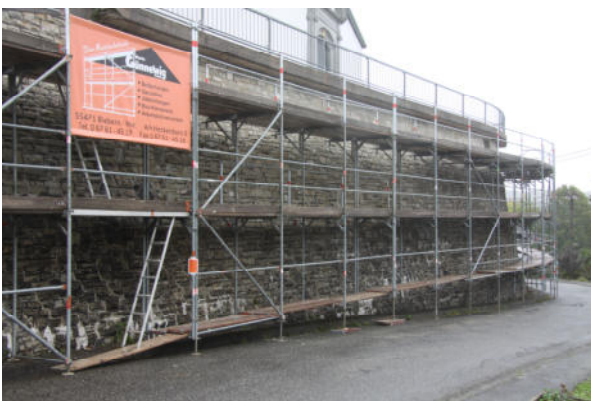
Stützmauer mit dem Baugerüst
